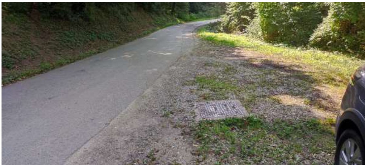
Fotografija 2-2: Početno okno magistralnog cjevovoda "Lobor -Mihovljan - Dukovec"
