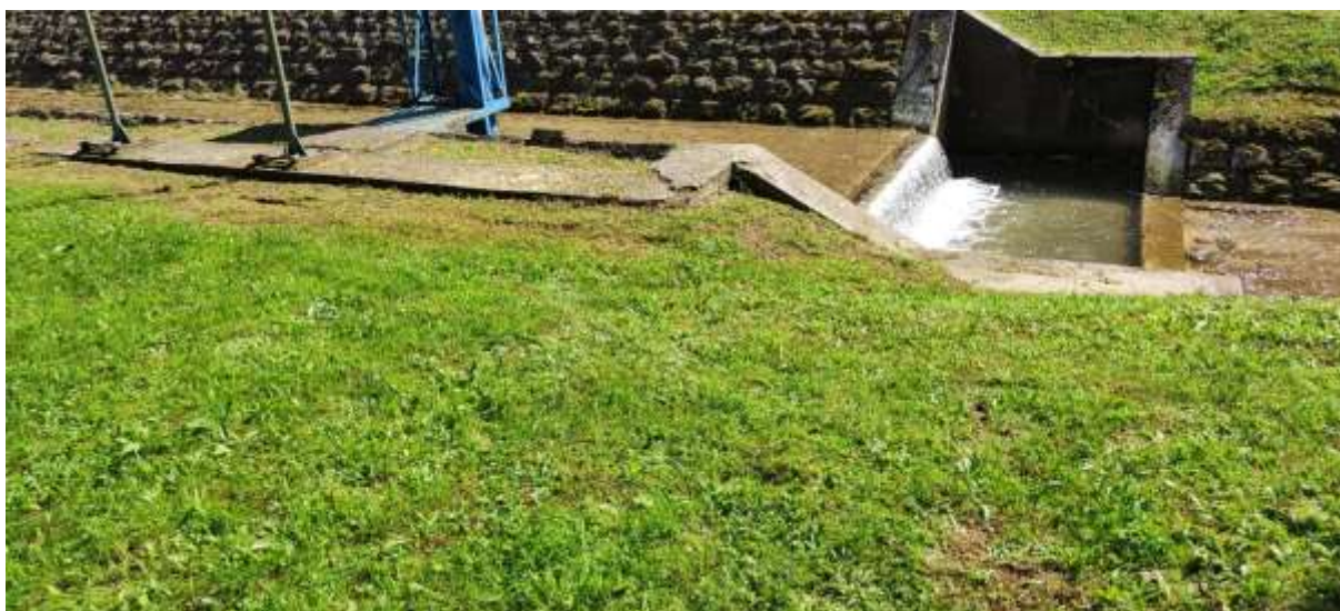
Fotografija 2-4: Lokacija okna za direktni pristup uz južnu stranu uređaja za kondicioniranje
